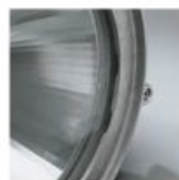
Drážka pro odvod vody
